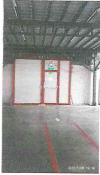
Üretim alanı 2. acil çıkış kapısı.jpg
