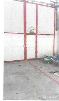
Üretim alanı 1. acil çıkış kapısı.jpg
