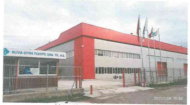
İşletme binası genel görünüm.jpg
